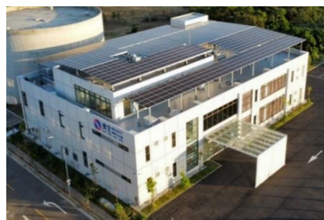
圖、觀光工廠建置太陽能發電設備
